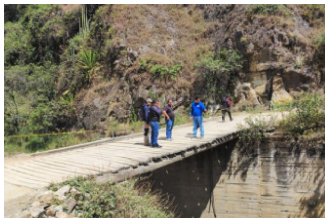
Imagen Nro. 36: Puente sobre el Rio Panasco
